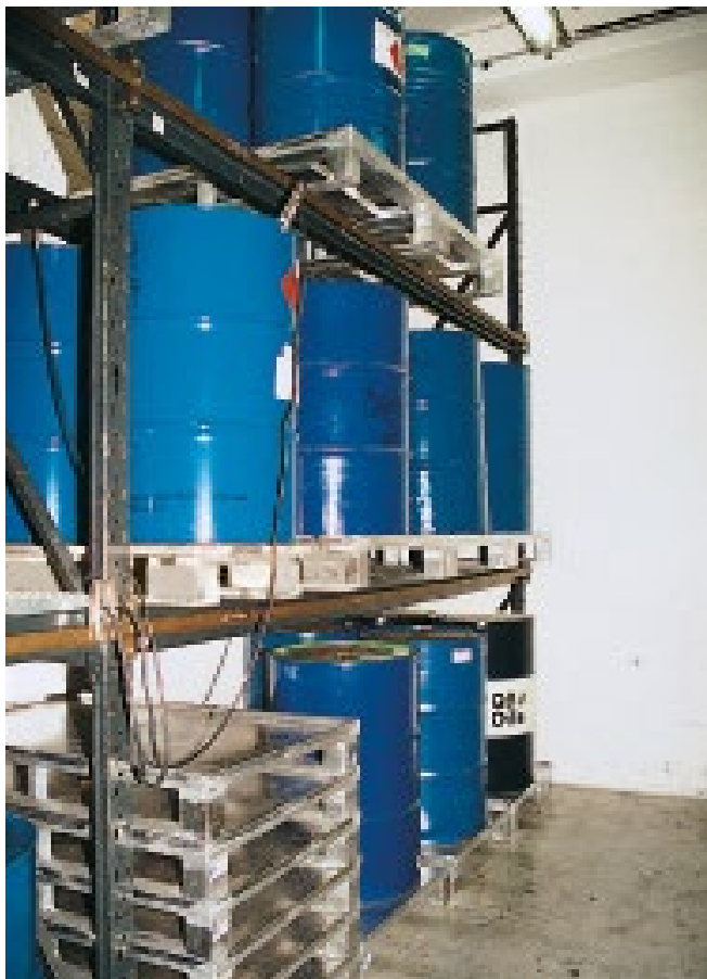
Abb. 23 Regale im Lacklager mit Potentialausgleich
