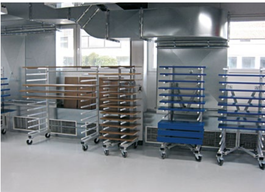
Abb. 36 Absaugung an Hordenwagen
