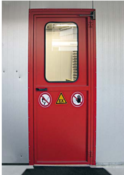
Abb. 18 Kennzeichnung an einem Zugang zum Lackiererraum
